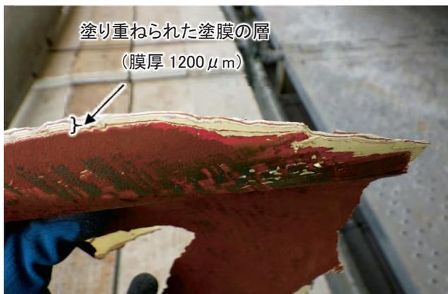
写真-1 IH 塗膜除去で剥離した塗膜片
