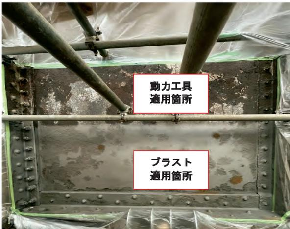
図-2 試験箇所の外観
