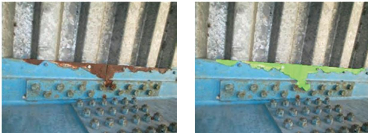
図-6 腐食画像のセマンティックセグメンテーション<sup>12)</sup>
