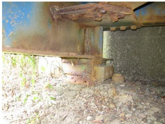
写真-2 鋼桁端部の著しい腐食事例
