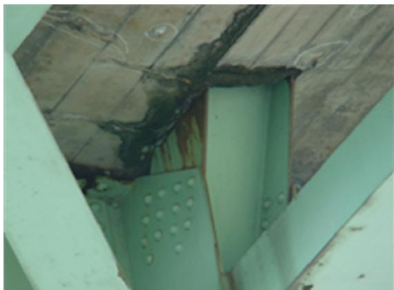
写真-1 鋼斜材が床版に貫通する部位の腐食
