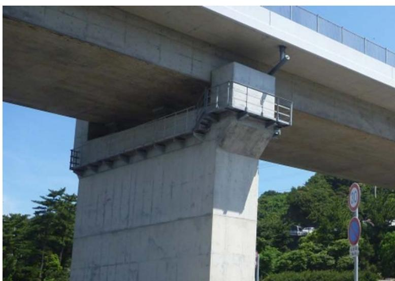
写真-3 下部構造検査路設置事例
